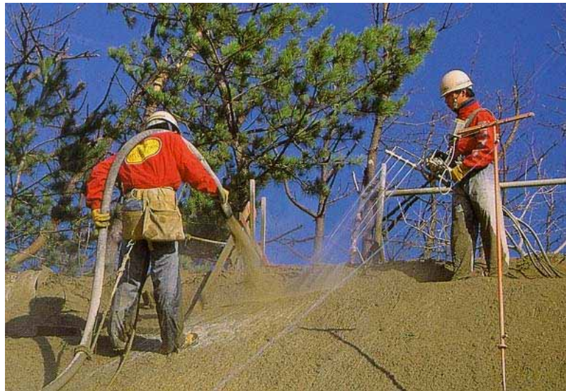
連続繊維補強土工施工状況
