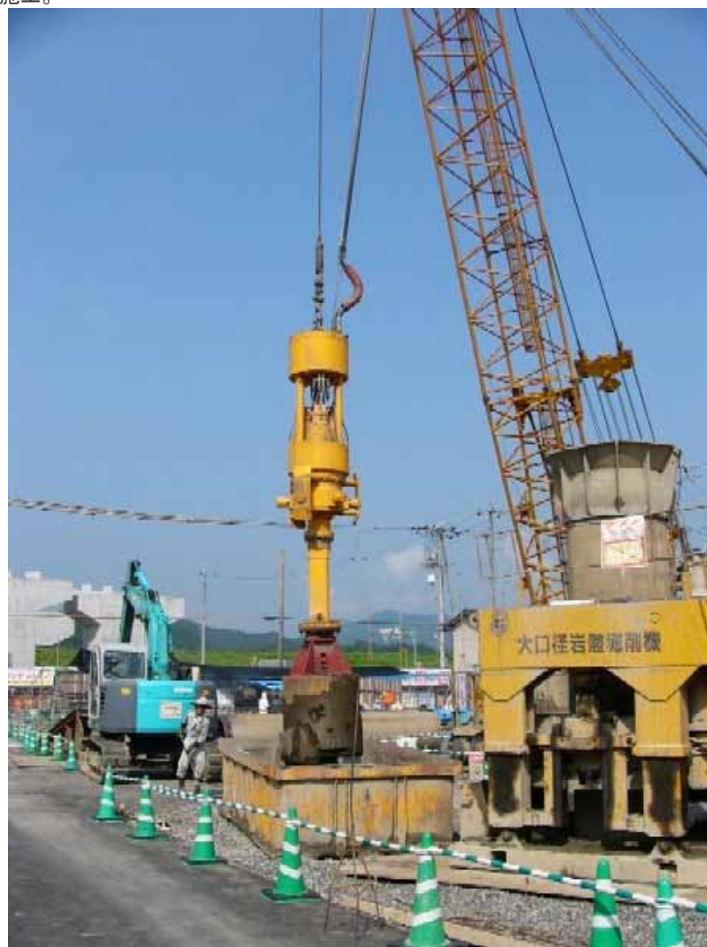
ハンディーバケット掘削状況
