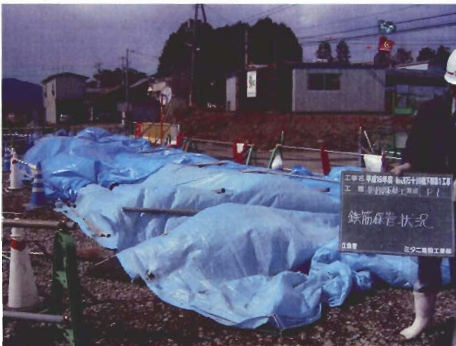
創意工夫 品質関係 鉄筋腐食防止処置 鉄筋保管状況 P1橋脚
