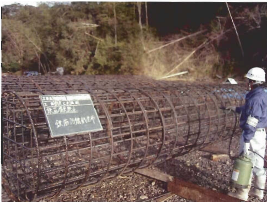
創意工夫 品質関係 鉄筋腐食防止処置 鉄筋帽錆剤使用 散布状況
