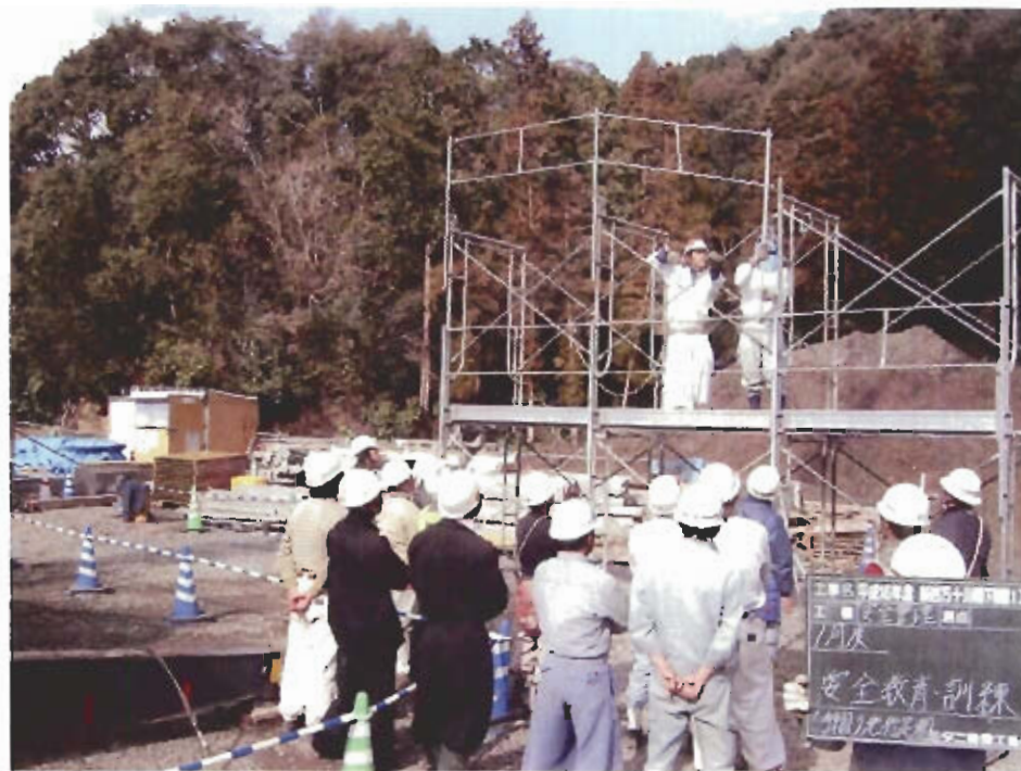
創意工夫 安全衛生関係 安全訓練 1月度安全教育訓練 手摺り先行足場組立
