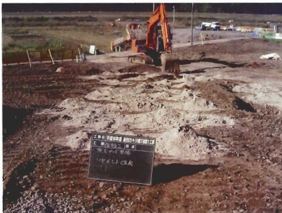
敷地造成工 整地工 セメント改良
