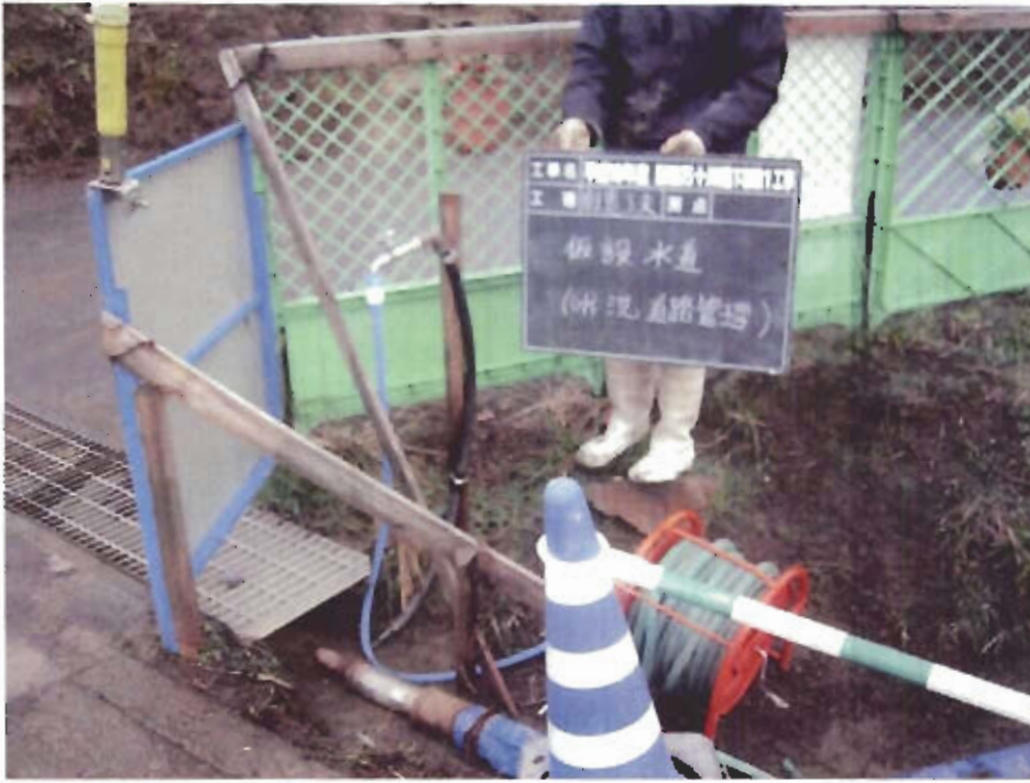
創意工夫 施工關係 仮設動力 仮設水道設置
