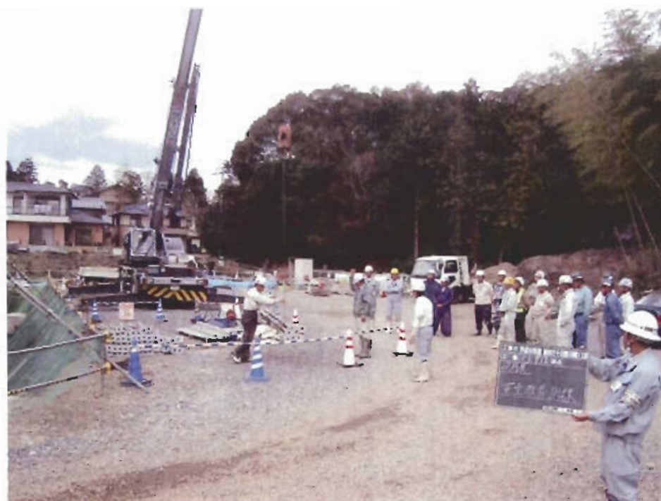
創意工夫 安全衛生関係 安全訓練 玉掛け作業
