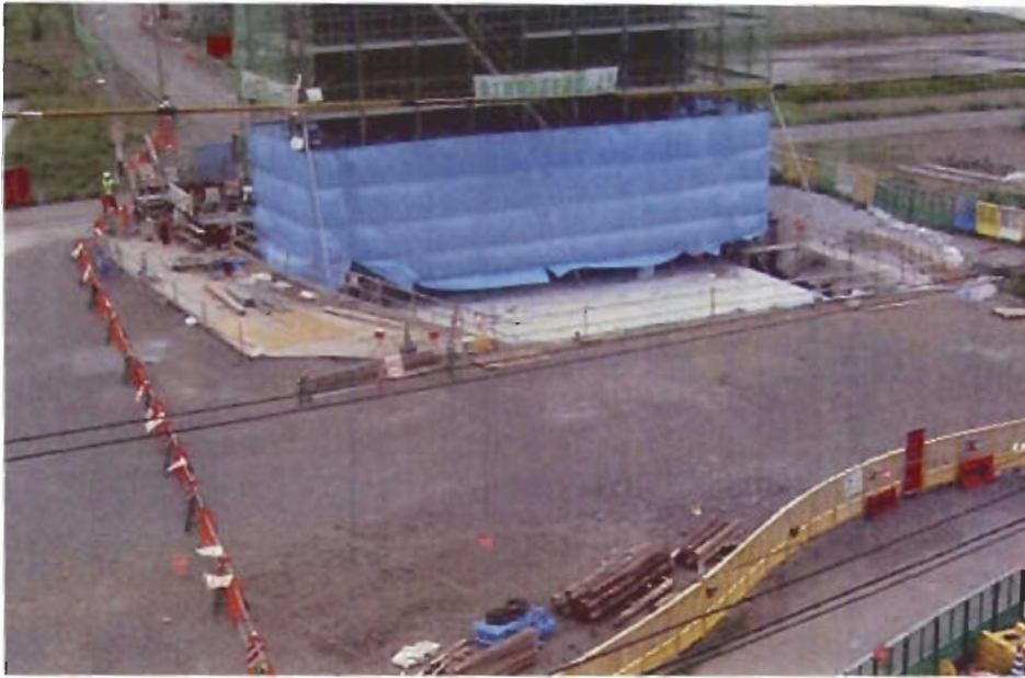
高度技術 自然・地盤条件 軟弱地盤対策 法面防護・作業架台 P1
