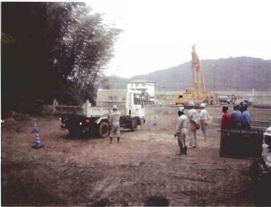
創意工夫 安全衛生関係 安全訓練 10月度実技訓練 車両誘導
