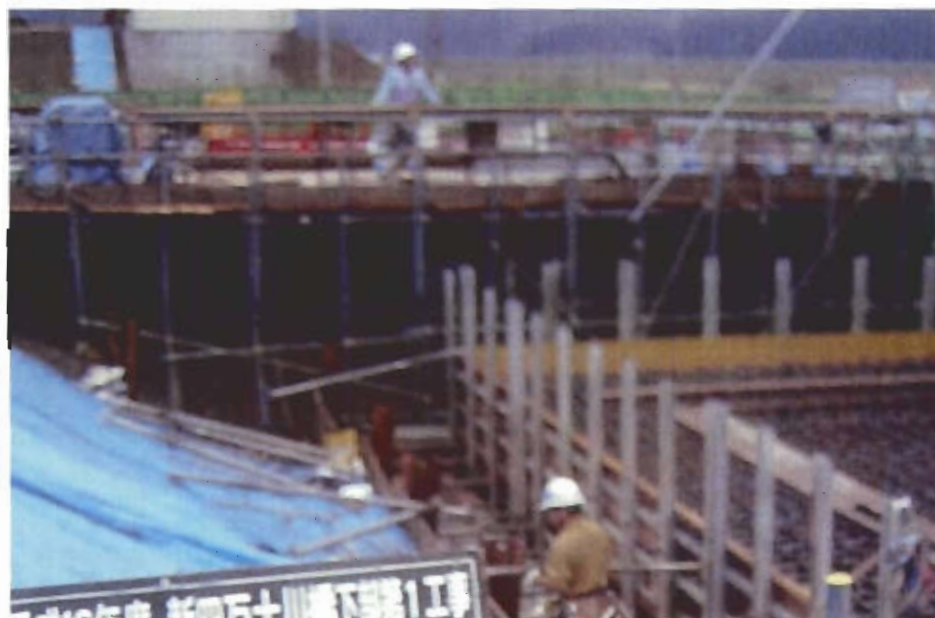
高度技術 自然・地盤条件 軟弱地盤対策 作業架台 P1
