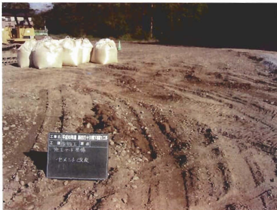
敷地造成工 整地工 セメント改良 改良前状態
