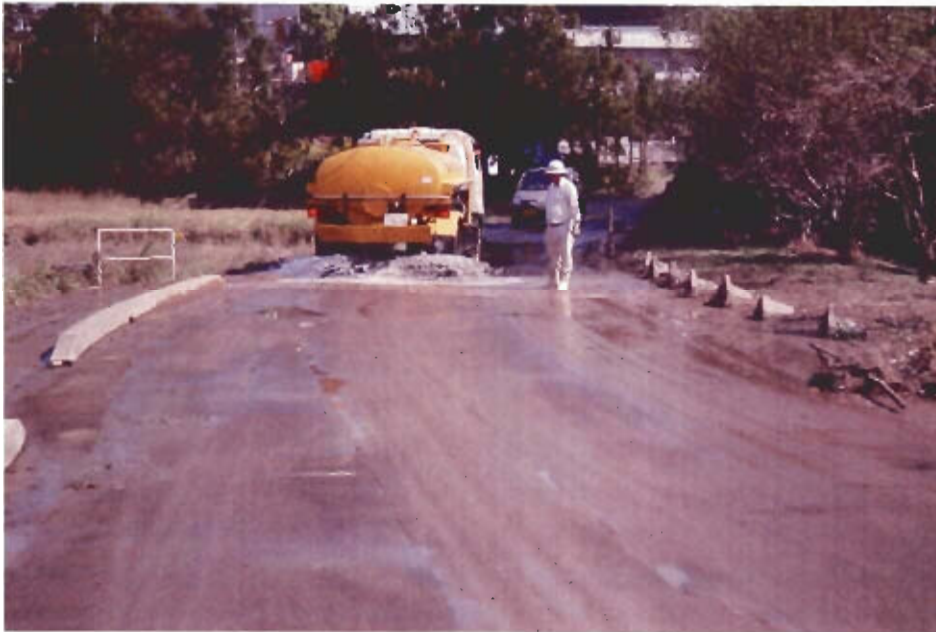
地域への貢献 台風23号災害復旧支援活動 冠水後道路清掃状況 市道
