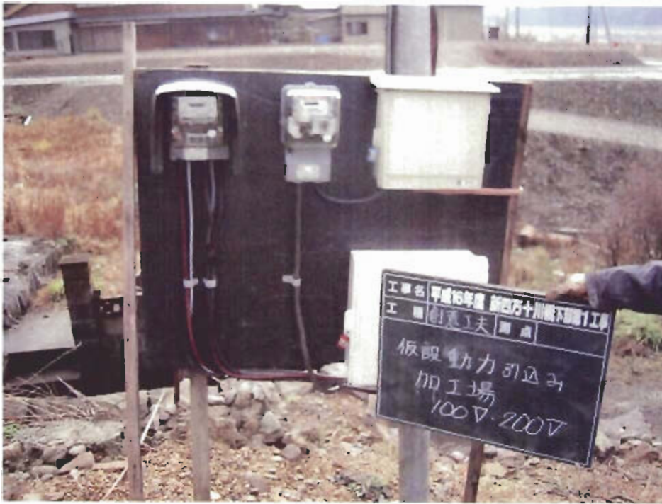
創意工夫 施工関係 仮設動力 100V・200V 加工場
