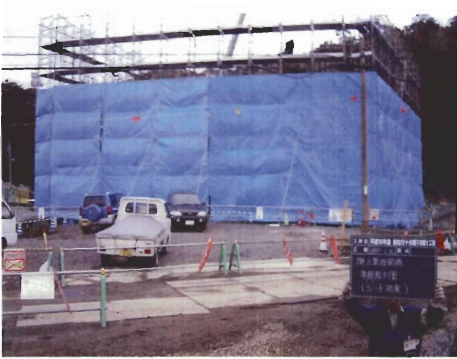
創意工夫 施工管理関係 季節風対策 シート被覆
