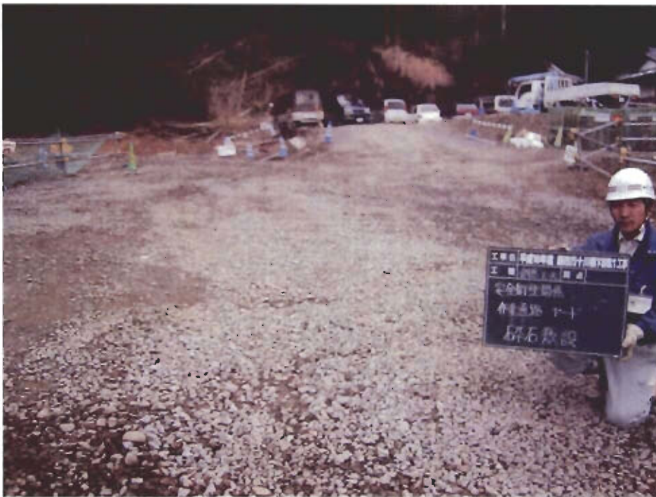
創意工夫 安全衛生関係 作業通路・ヤード 砕石敷設
