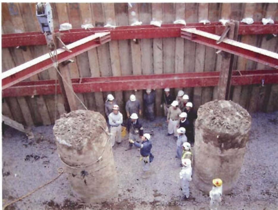
創意工夫 安全衛生関係 安全訓練 1月度安全教育訓練 重量物の玉掛け作業
