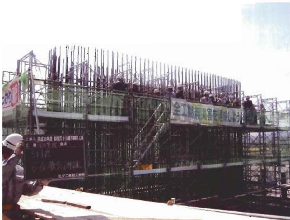
創意工夫 安全衛生関係 安全訓練 3月度安全教育訓練 安全帯の点検と取付け位置
