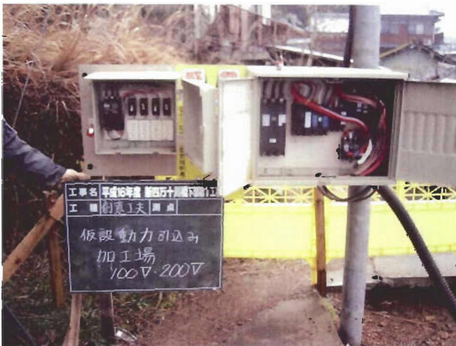
創意工夫 施工関係 仮設動力 100V・200V 加工場
