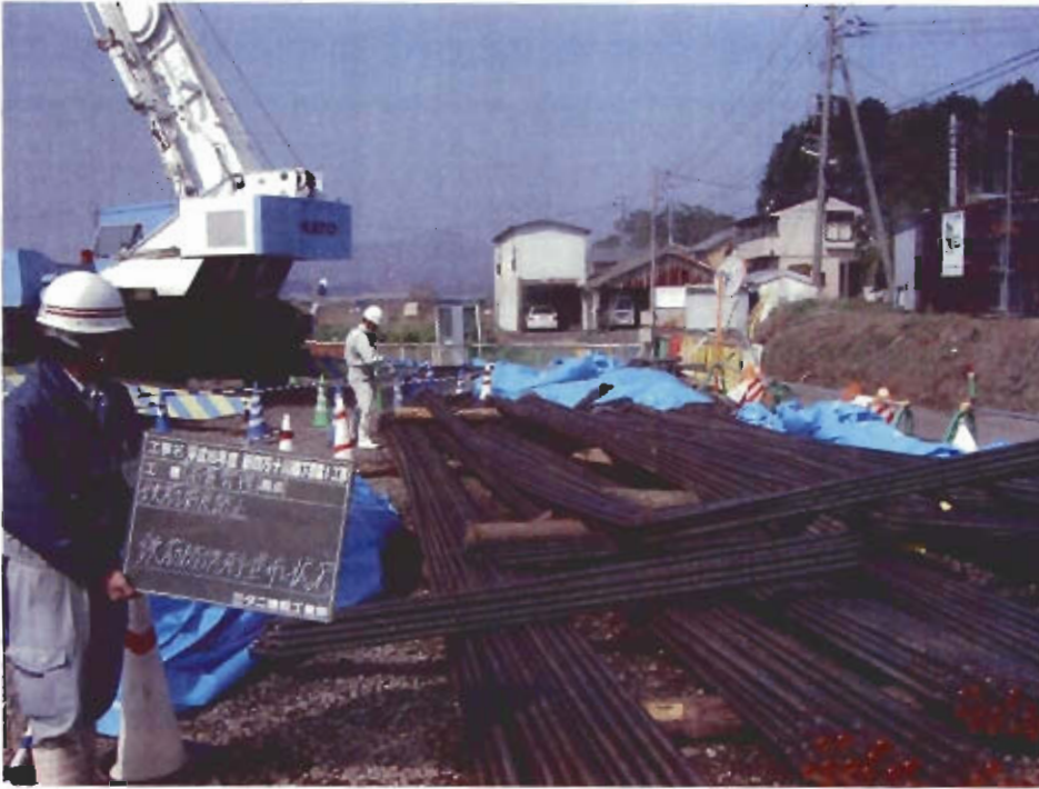
創意工夫 品質関係 鉄筋腐食防止処置 鉄筋防錆剤塗布
