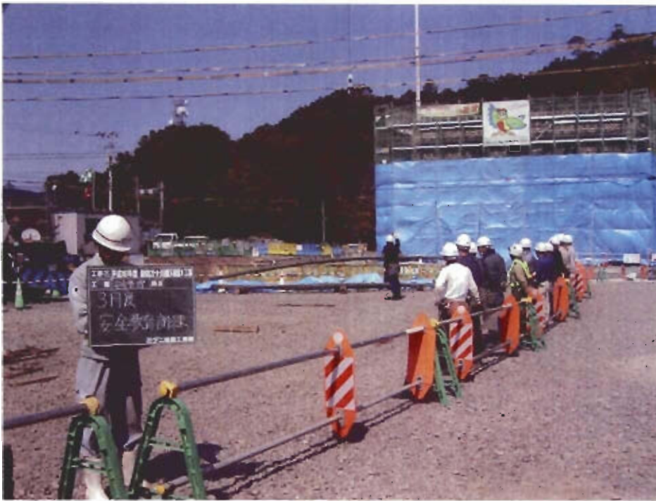
創意工夫 安全衛生関係 安全訓練 3月度安全教育訓練 長尺物の玉掛け作業
