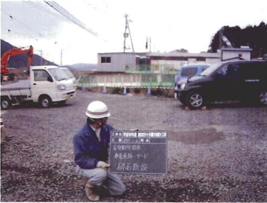
創意工夫 安全衛生関係 作業通路・ヤード 碎石敷設
