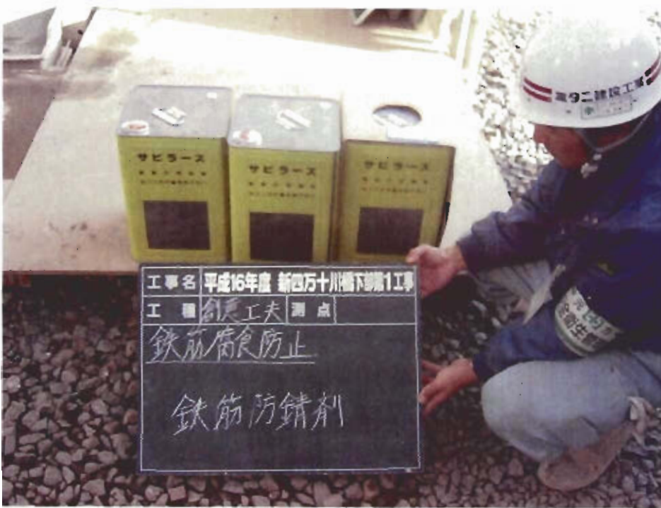
創意工夫 品質関係 鉄筋腐食防止処置 鉄筋防錆剤使用
