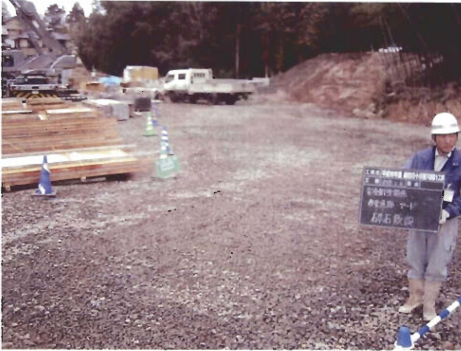
創意工夫 安全衛生関係 作業通路・ヤード 砕石敷設
