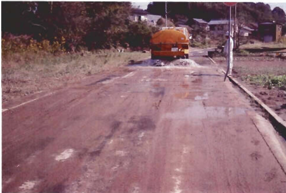
地域への貢献 台風23号災害復旧支援活動 動 冠水後道路清掃状況 市道
